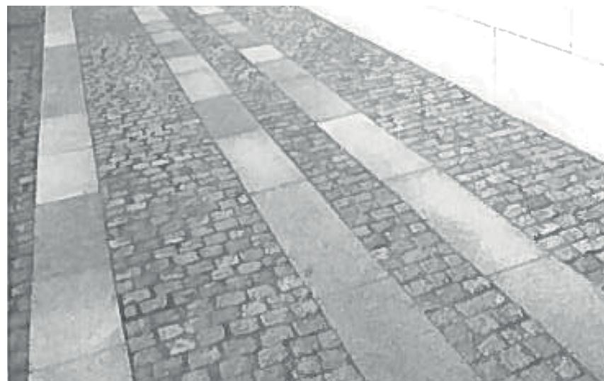
Chaussesten og bordurbånd på fortove
