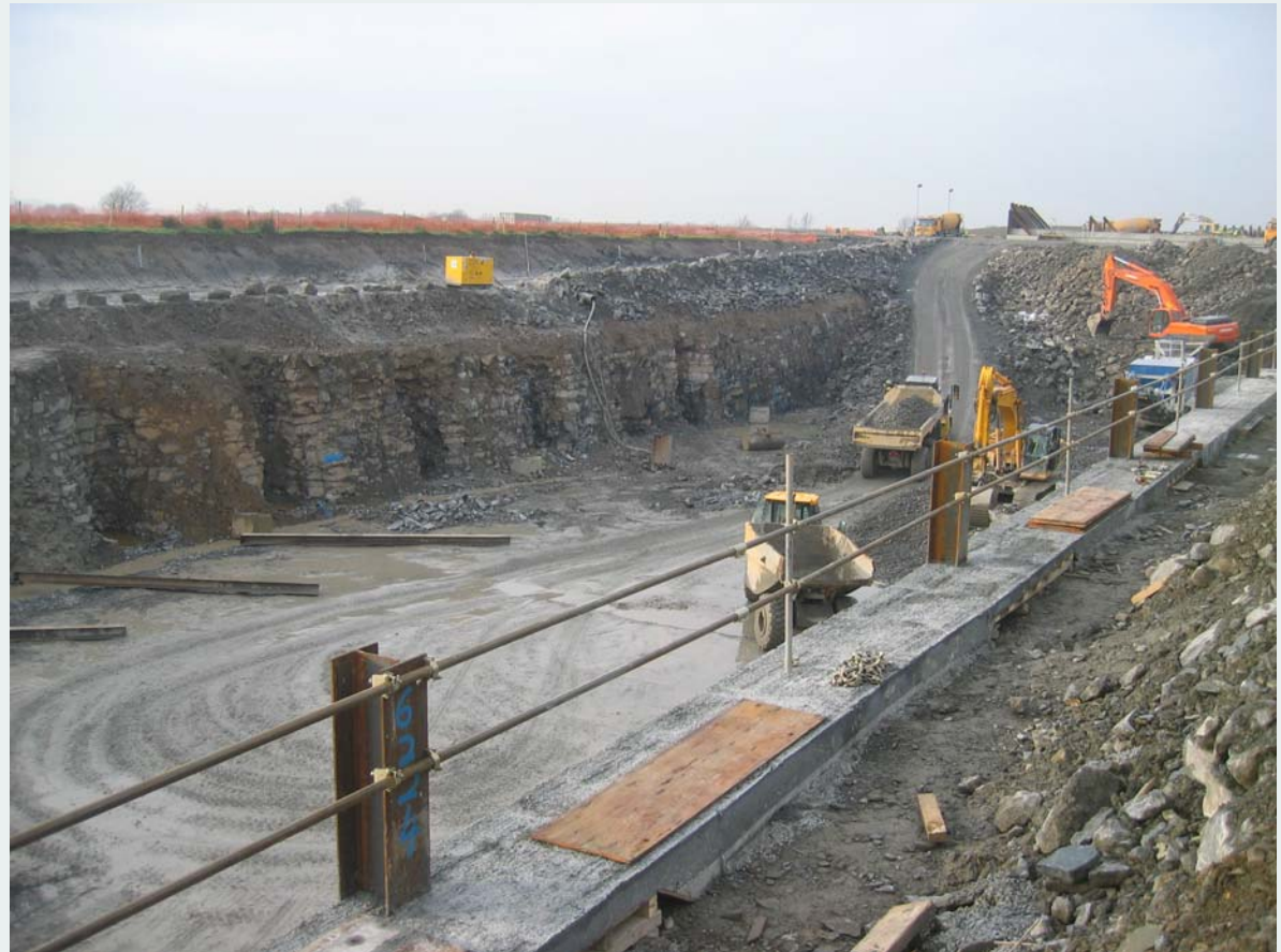
Udgravning til tørdok og nordlig Cut & Cover tunnel og rampe
