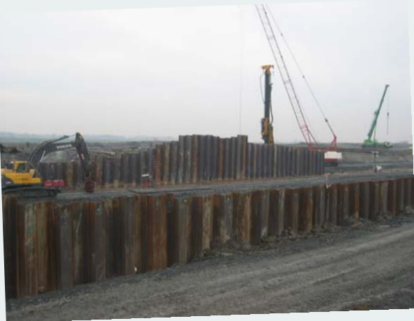
Udgravning til tørdok og nordlig Cut & Cover tunnel og rampe
